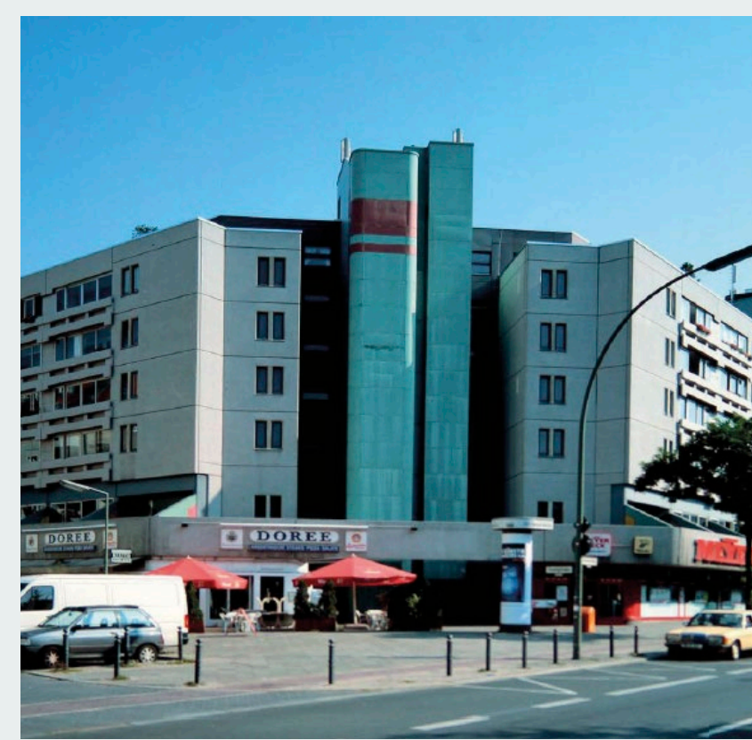
Eckbetonter Blockabschluss 1988 (Dominicusstraße, Ecke Feurigstraße) mit grünlichen Treppenhäusern
